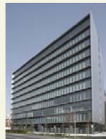
KDX Harumi Bldg
