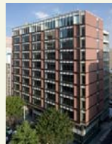
KDX Nagoya Sakae Bldg
