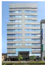
KDX Mita Bldg.
