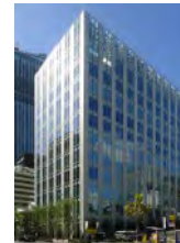
KDX Toranomom 1chome Bldg.
