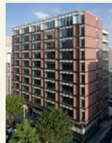
KDX Nagoya Sakae Bldg
