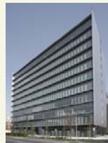
KDX Harumi Bldg
